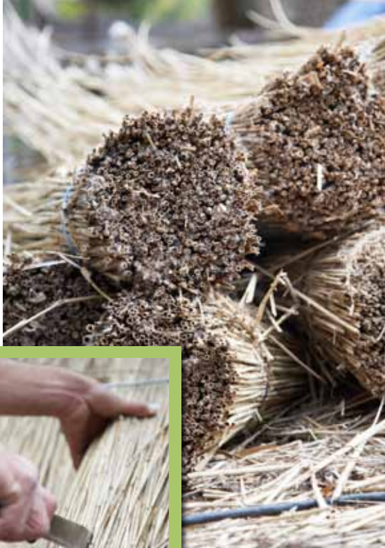
Foto rechterpagina: Nadat de bos riet op het dak gelegd is, wordt die met behulp van een drijfboard helemaal op de juiste plaats gelegd.
