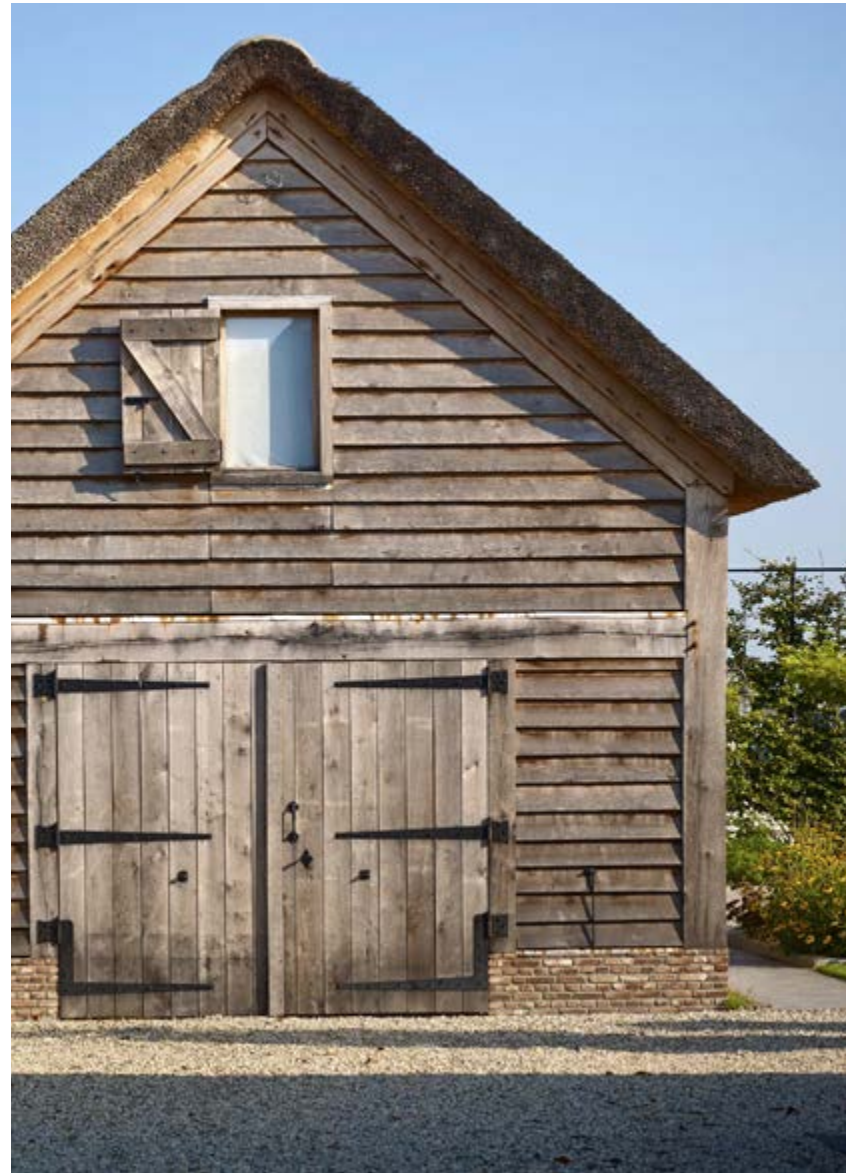
De voorgevel van het bijgebouw werd geheel in eiken opgetrokken.
